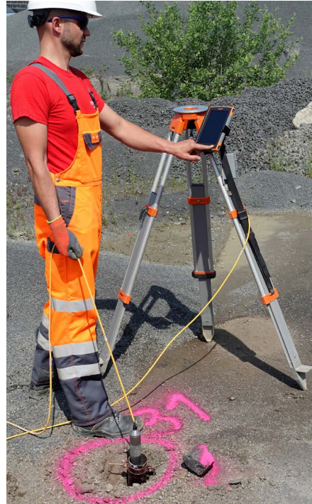
Abb. 31 Messung des Bohrlochverlaufs mit einer Bohrlochsonde
