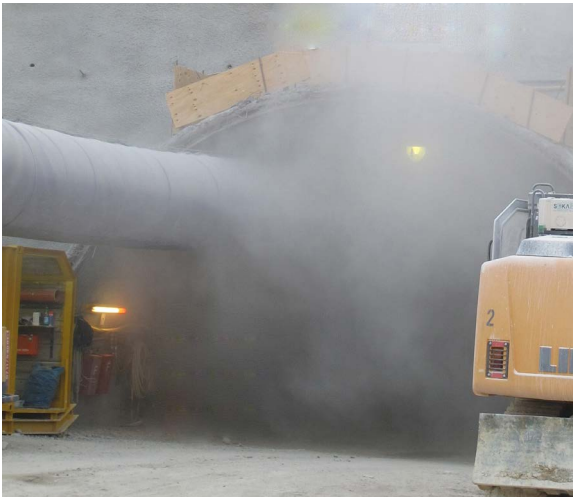
Abb. 40 Abziehende Sprengschwaden am Tunnelportal
