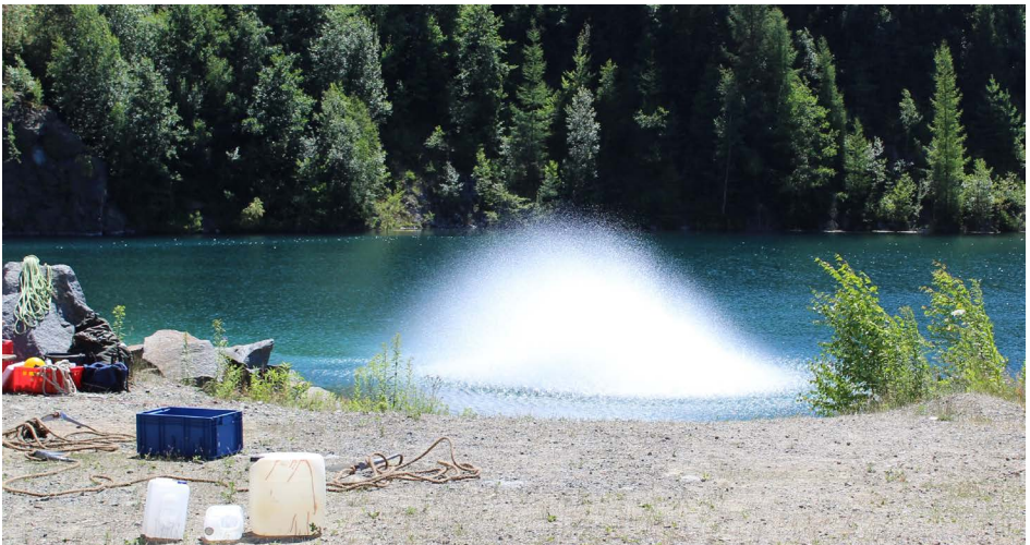
Abb. 42 Sprengung unter Wasser
