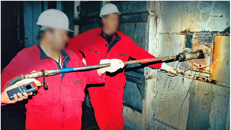
Abb. 43 Einbringen einer wassergekühlten Ladung zur Durchführung von Sprengarbeiten in heißen Massen
