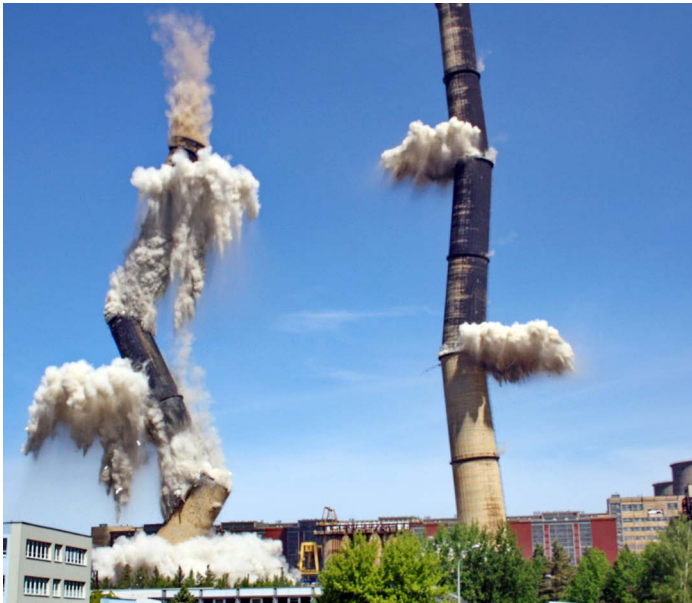
Abb. 41 Bauwerkssprengung
